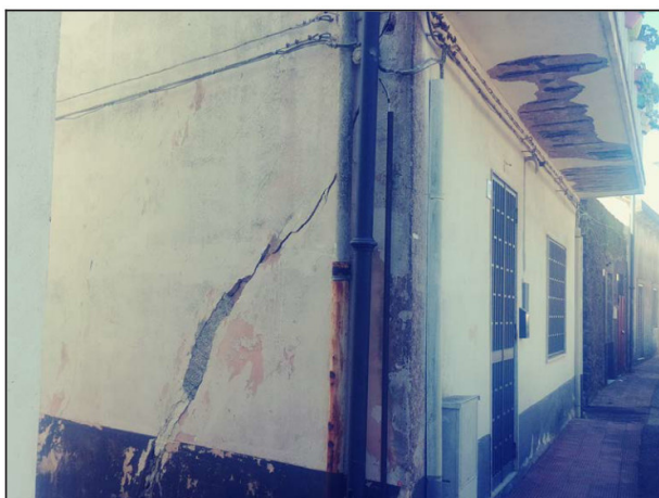
Fig. 66 – A sinistra Vico di Stefano n. 40. Fessura beante a circa 45° – A destra Fessurazioni su un edificio ubicato in Vico Immacolata.
