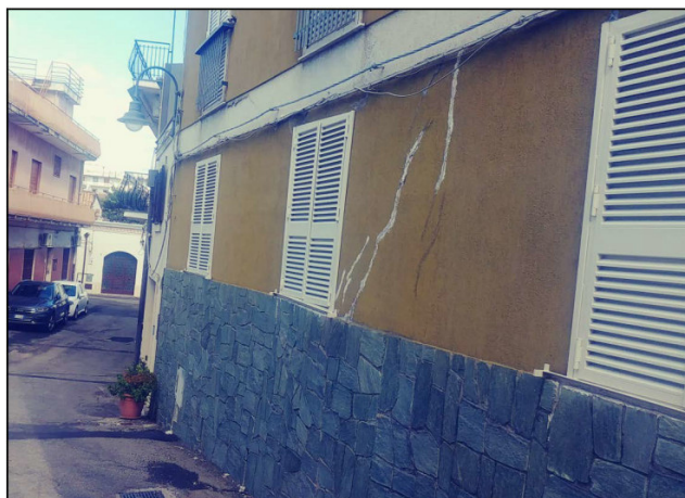
Fig. 66 – A sinistra Vico di Stefano n. 40. Fessura beante a circa 45° – A destra Fessurazioni su un edificio ubicato in Vico Immacolata.
